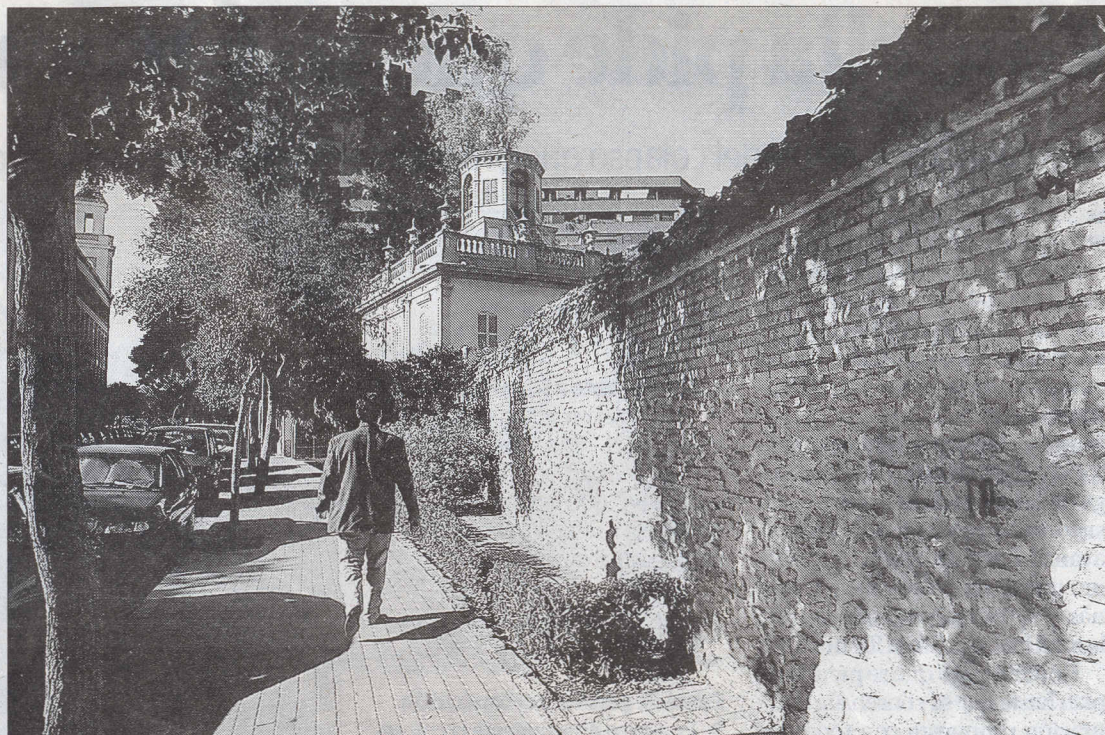
Tramo del muro que caerá en la calle Monforte, con el palacete de bodas al fondo. M. MOLINES
